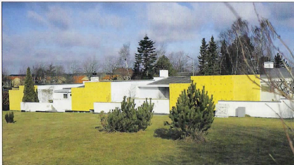
Når man giver husene en facaderenovering kommer man samtidigt mange fugtproblemer til livs.
